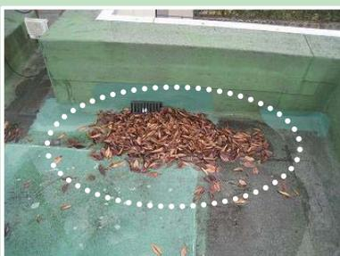
屋上の排水口（ルーフドレイン）や軒樋に落ち葉やゴミがたまると排水不良となり、漏水の原因となります。屋上の点検等に併せて、可能な範囲で清掃してください。
