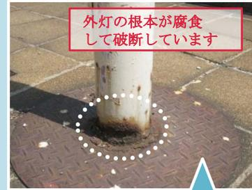
金属製の構造物は根本が腐食しやすいので、注意して点検してください。
