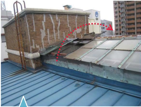
強風により天窓があおられて破損し、ガラスが飛散しました。
