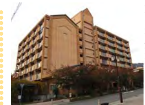
六甲道駅北地区 六甲住宅(61戸)
