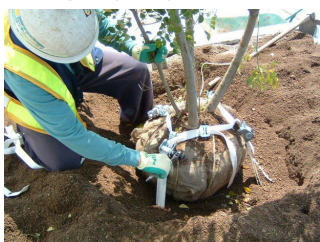
■地下支柱の例
