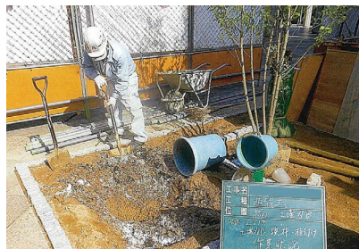
土壤改良資材の混入状況
