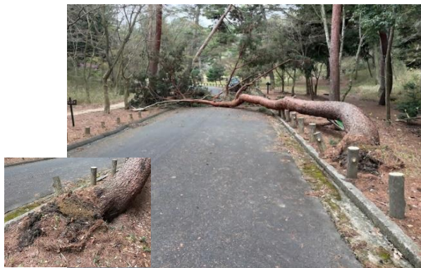
2026年4月7日、地際の腐食が原因で倒れた松
