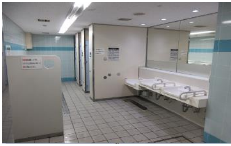
▲名谷駅トイレ高質化工事（工事前）
