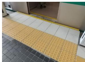
▲隙間・段差解消後
