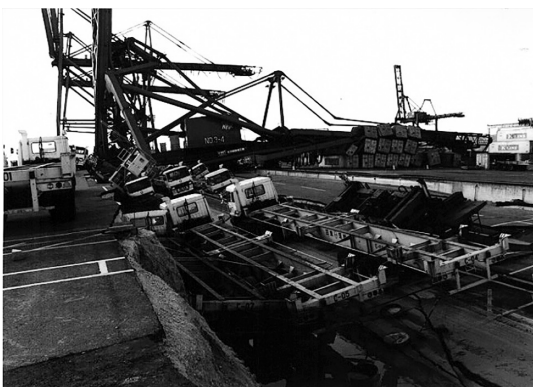
六甲アイランドのコンテナターミナルの被災状況
