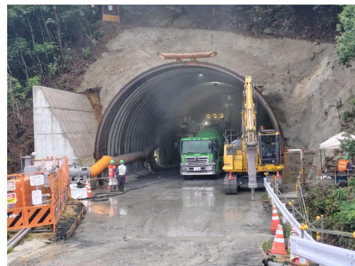
②トンネル坑口全景1・コンクリート一次吹付
