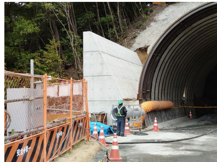
②トンネル坑口全景1・コンクリート一次吹付
