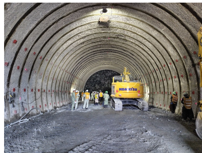
④トンネル坑内全景・ロックボルト打込み状況
