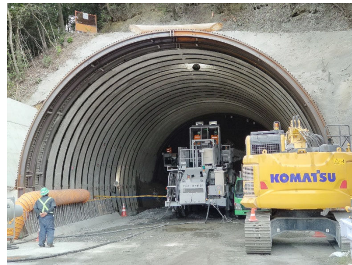
④トンネル坑内全景・ロックボルト打込み状況
