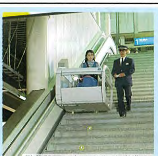
階段設置の車いすリフト（例）▲
