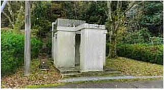
有馬斎場のトイレ工事完成前
