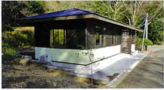
有馬斎場のトイレ工事完成後
