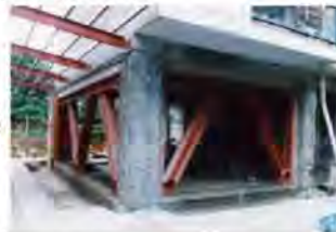
（工事中の写真）
