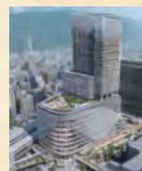
JR 三ノ宮新駅ビル (仮称) 2029 年度開業
