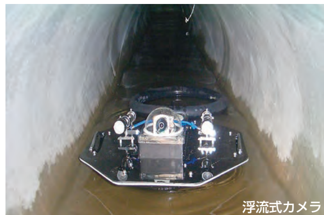
マンホール内の目視調査
