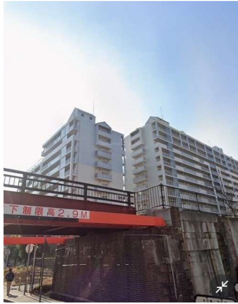
現況：神戸臨港線跡の庄境架道橋付近
