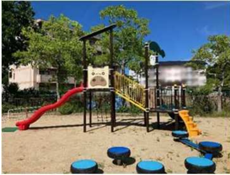
遊具の改築更新 (垂水区 奥畑公園)
