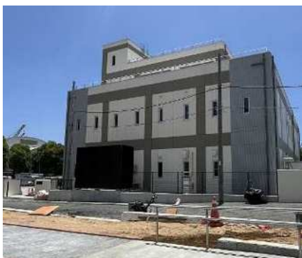
新東川崎ポンプ場（中央区）
