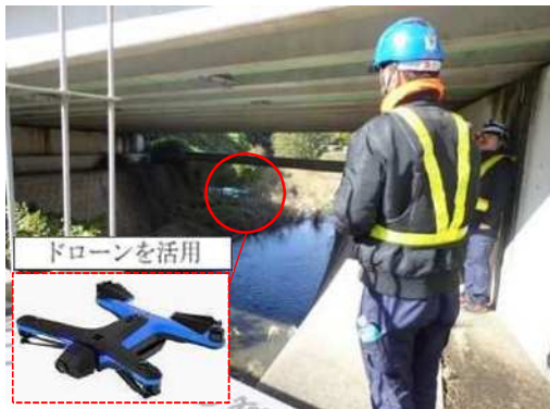
橋梁点検（西区 見津橋）
