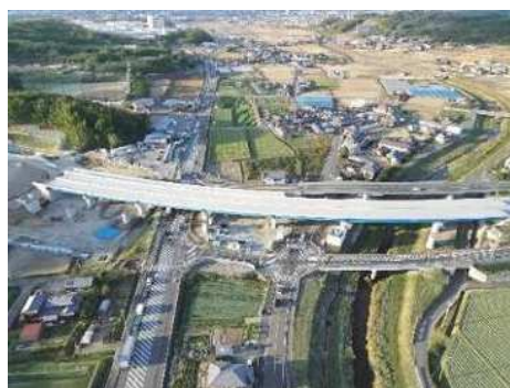
神戸西バイパス 整備状況（西区榎谷町）
