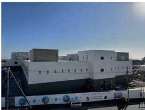
西部処理場北系整備（長田区）
