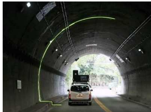
トンネル点検（北区 岩山東トンネル）
