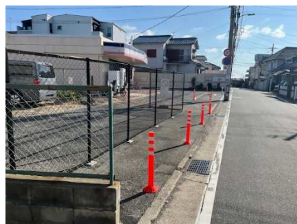
霞ヶ丘現道改良（歩行者退避空間の設置）
