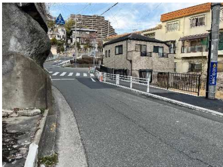
塩屋現道改良（歩車道の一部拡幅）
