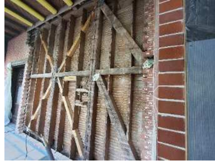
風見鶏の館 補強状況
