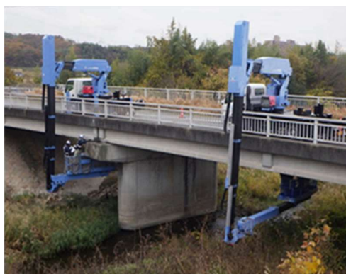
橋梁点検車による点検
