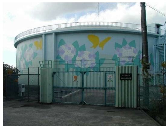
西神低層配水池
