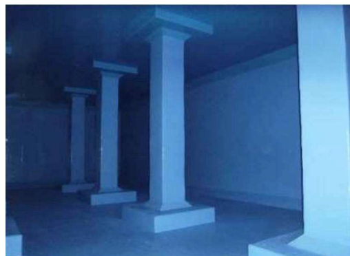
配水池の内面
