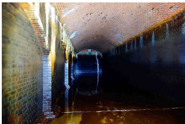
奥平野低層配水池
