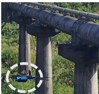
ドローンによる点検
