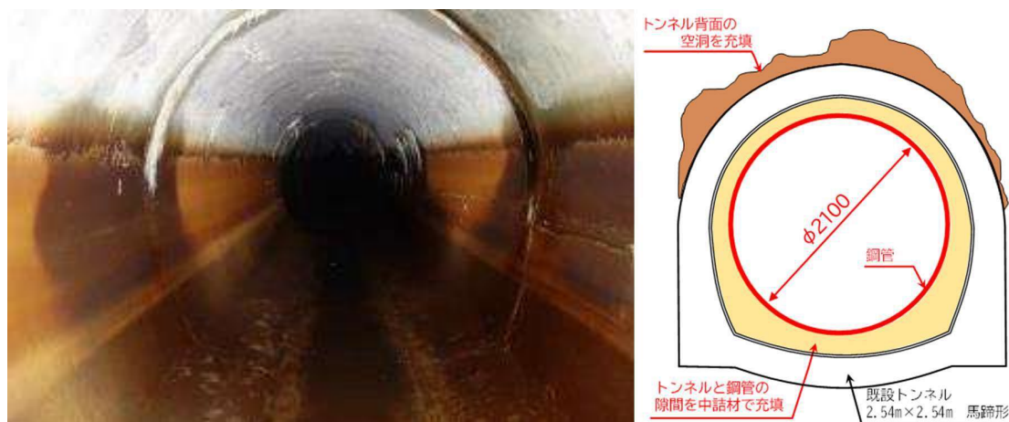
4 拡送水トンネル
