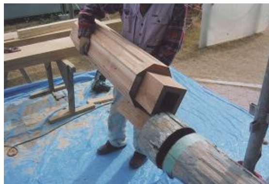
ベランダ柱材の補修
